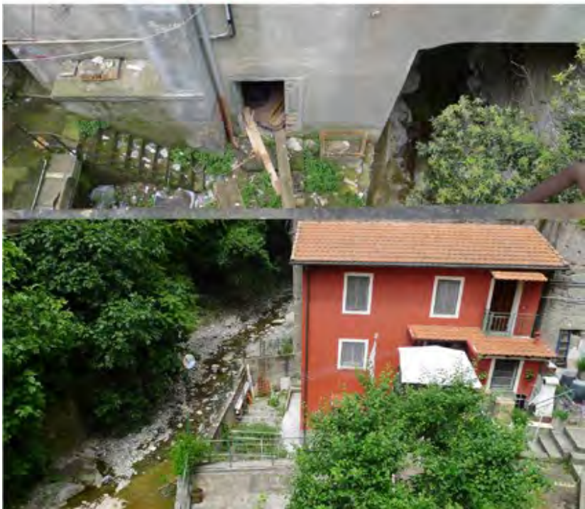
Immagine 2 | Sistemi allagati, case argine.
