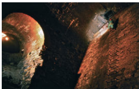
Fig. 4 - I grandi spazi all'interno del Ponte Monumentale. È visibile la scarpa delle vecchie mura (foto di G. Barranco, Archivio Centro Documentazione CSS)
