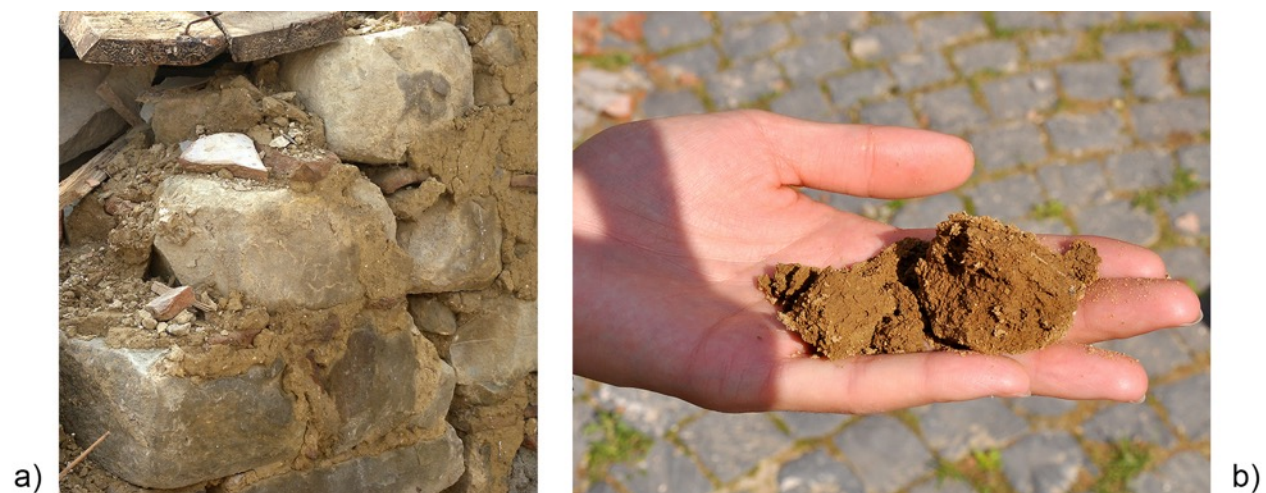
Fig. 5. Mud mortar in: a) Accumoli, Illica, and b) Amatrice, Sant'Angelo.
