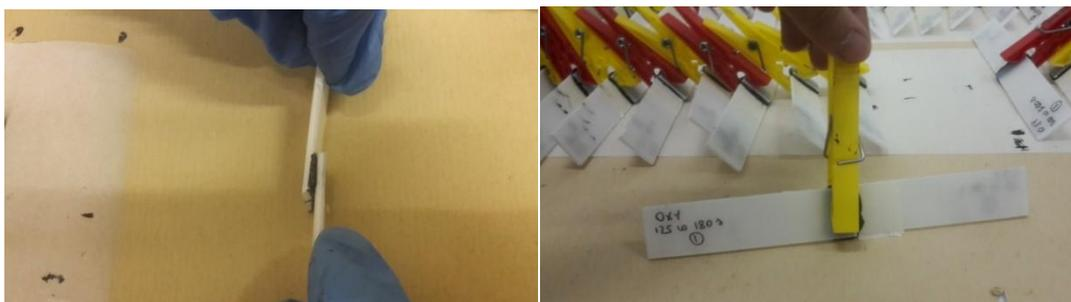
Fig. 46 – Ultime fasi dell'incollaggio: unione e pressione del giunto
