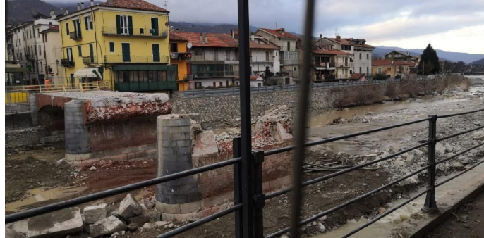
Fig. 3 : La démolition volontaire du pont Odasso sur le Tanaro à Garessio, 31.10.2020. Photo : Stefania Marengo
