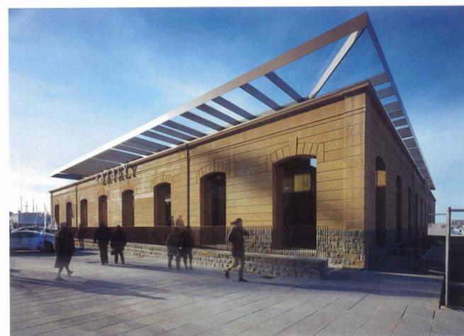
Il nuovo store Eataly nasce sul Porto di Trieste con un progetto di trasformazione dell'ottocentesco ex magazzino del vino. Il nuovo edificio non modifica la struttura del vecchio, ma si inserisce al suo interno.
