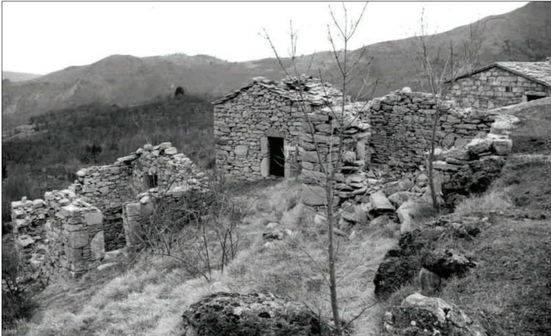
Figure 6.2 Casoni of Lavaggi di Chiappozzo (820 m.a.s.l.), upper Graveglia valley (from Ferrando Cabona and Mannoni 1989:157, fig. 167).
