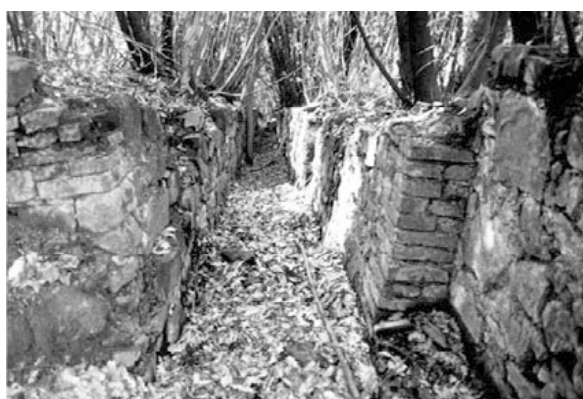
Fig. 12 – La trincea maggiore dell'uccelliera; si noti la tecnica costruttiva composta in elementi litici e mattoni.
