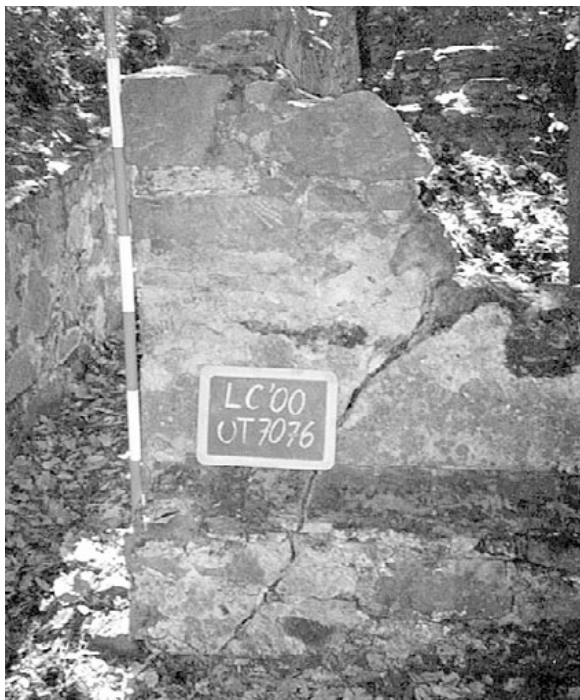
Fig. 5 – Particolare di una delle due panche in muratura esterne al capanno.
