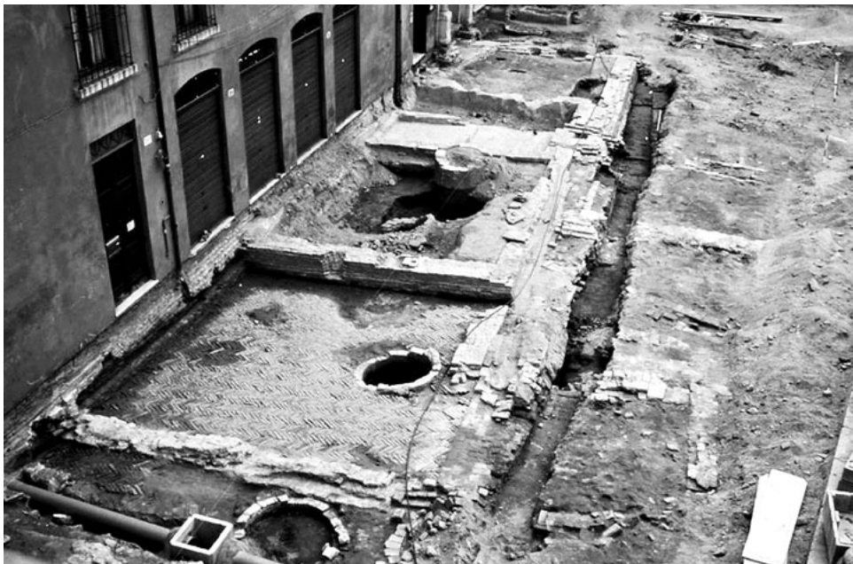
fig. 15 – Ferrara, piazza Municipale, lato nord, vasca rettangolare per la captazione dell'acqua.
