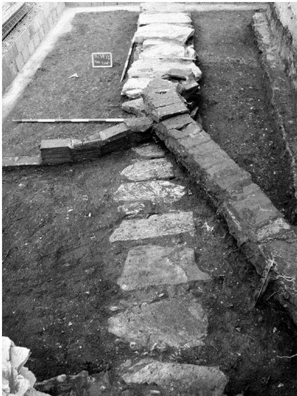
fig. 19 - Pisa. La fognatura tardo ottocentesca, vista da Sud, con le lastre litiche di copertura e le canalette in laterizi soprastanti.
