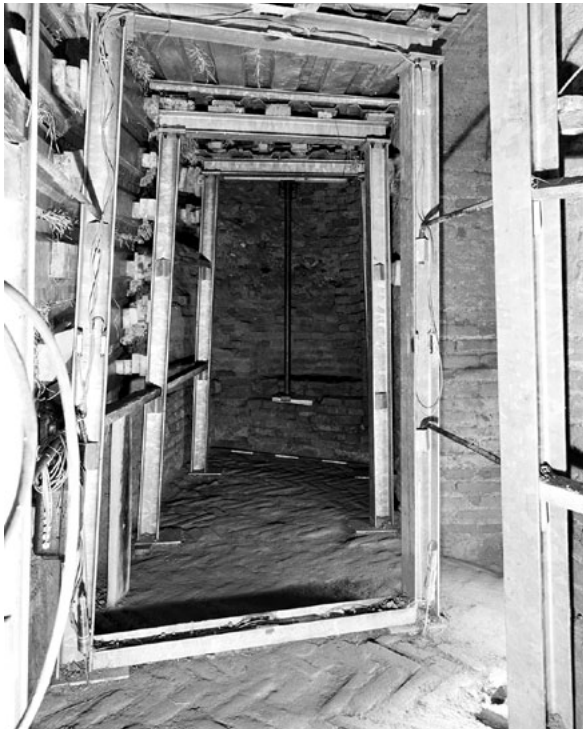
fig. 2 – Scavo del tratto terminale inferiore della rampa elicoidale rinvenuta nel 2006 al di sotto della scuola "E. Ricardi di Netro".
