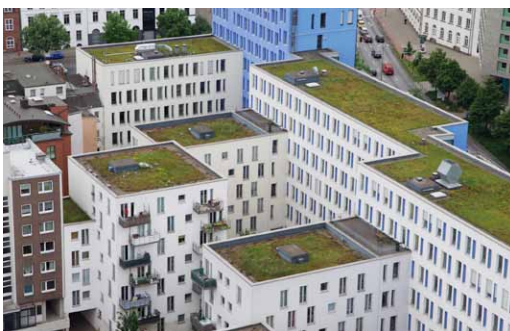
Figura 2.5. Coperture verdi estensive, Amburgo (Germania)
