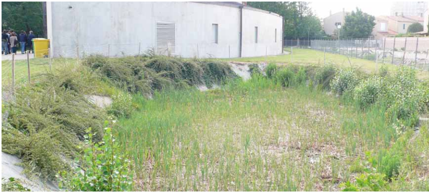
Figura 2.7. Infiltration basin, Avignone (Francia)
