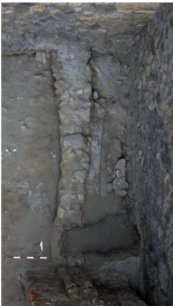
Fig. 14. VII. 14. 1. Dettaglio della struttura muraria in opus incertum 1501. Per il posizionamento del contesto nell'ambito del civico 1, cfr. fig. 13.
