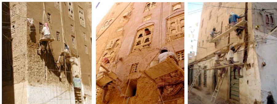
Fig. 7 – Rivestimento delle murature con malta di terra-fango.
