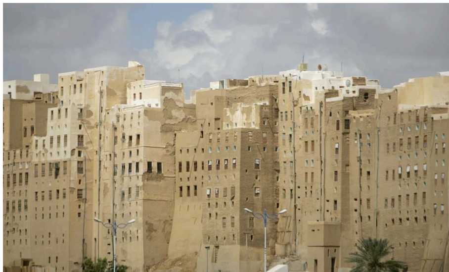
Fig. 13 – Edifici dell'antica città di Shibam il 28 ottobre 2008 dopo la devastante alluvione che ha colpito lo Yemen del sud-est distruggendo centinaia di case di terra-fango e lasciando decine di morti e dispersi. Si possono osservare le facciate degli edifici con le lacune nei rivestimenti e alcune costruzioni senza le coperture.
