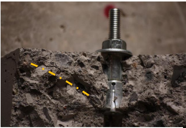
Figure 7 - Free crack growth / propagazione della frattura senza il contrasto del martino
