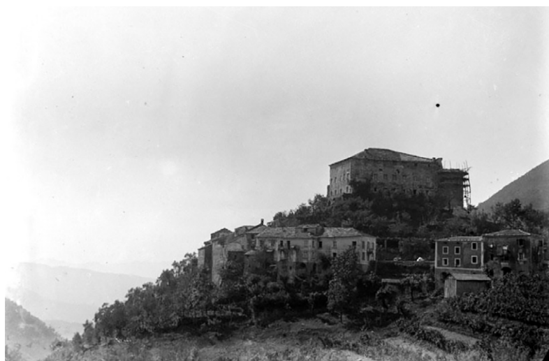
Fig. 3. La torre in fase di ricostruzione dopo il terremoto del 1920 (Archivio storico fotografico digitale Raffaelli di Bagnone, < https://archiviofotografico/archiwebmassacarrara.com > [14/11/2023]). Si tratta di un evento finora non indagato, che ha causato importanti danni all'intera struttura e ha comportato non solo la parziale ricostruzione della torre, ma anche risarcimenti e consolidamenti di cui è importante conoscere la storia.
