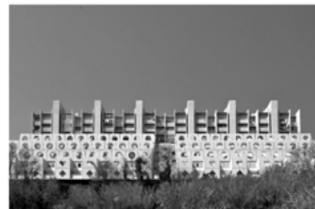
Vista Ovest blocco Nord delle Lavatrici
