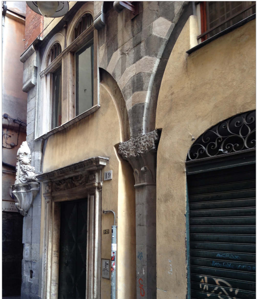
fig. 1 – Genova. Via delle Grazie, edificio stratificato in cui lo scrostamento (1922) ha fatto emergere, dietro la sistemazione quattrocentesca (portale e finestra binata), la loggia e al piano superiore i profili di due polifore di mattoni (foto dell'autrice, 2015)
