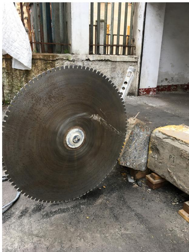
Fig. 2. Genova, cantiere dell'ex-mercato ortofrutticolo di corso Sardegna, taglio di un pilastro in c.a. operato da Taglio Cem sas (foto R. Vecchiattini 2020).
