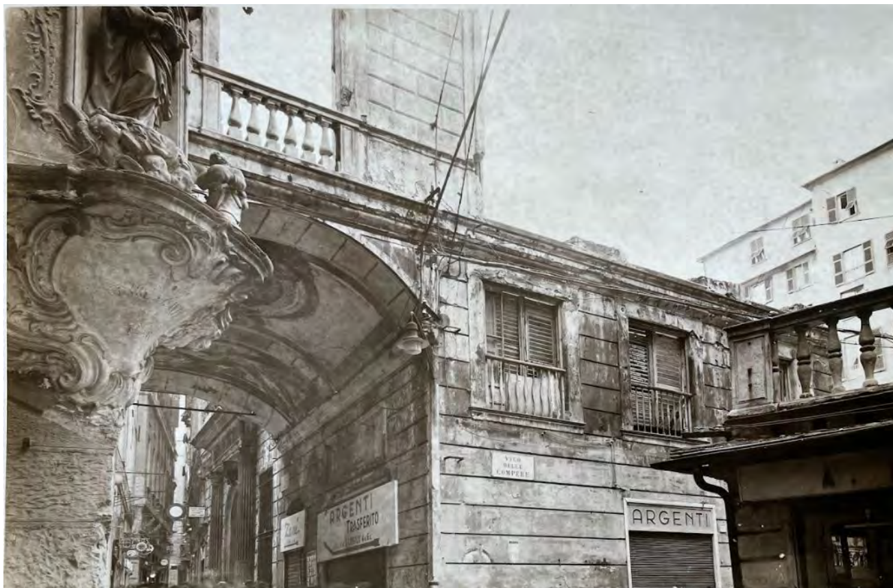
2: Genova, Palazzo Penco, 1954. L'edificio dopo la demolizione delle parti pericolanti operata dal Genio civile. Oltre l'archivolto si intravede il portale conservato (Archivio SABAP, pratica Ge-Molo, MON 14 Palazzo Penco).
