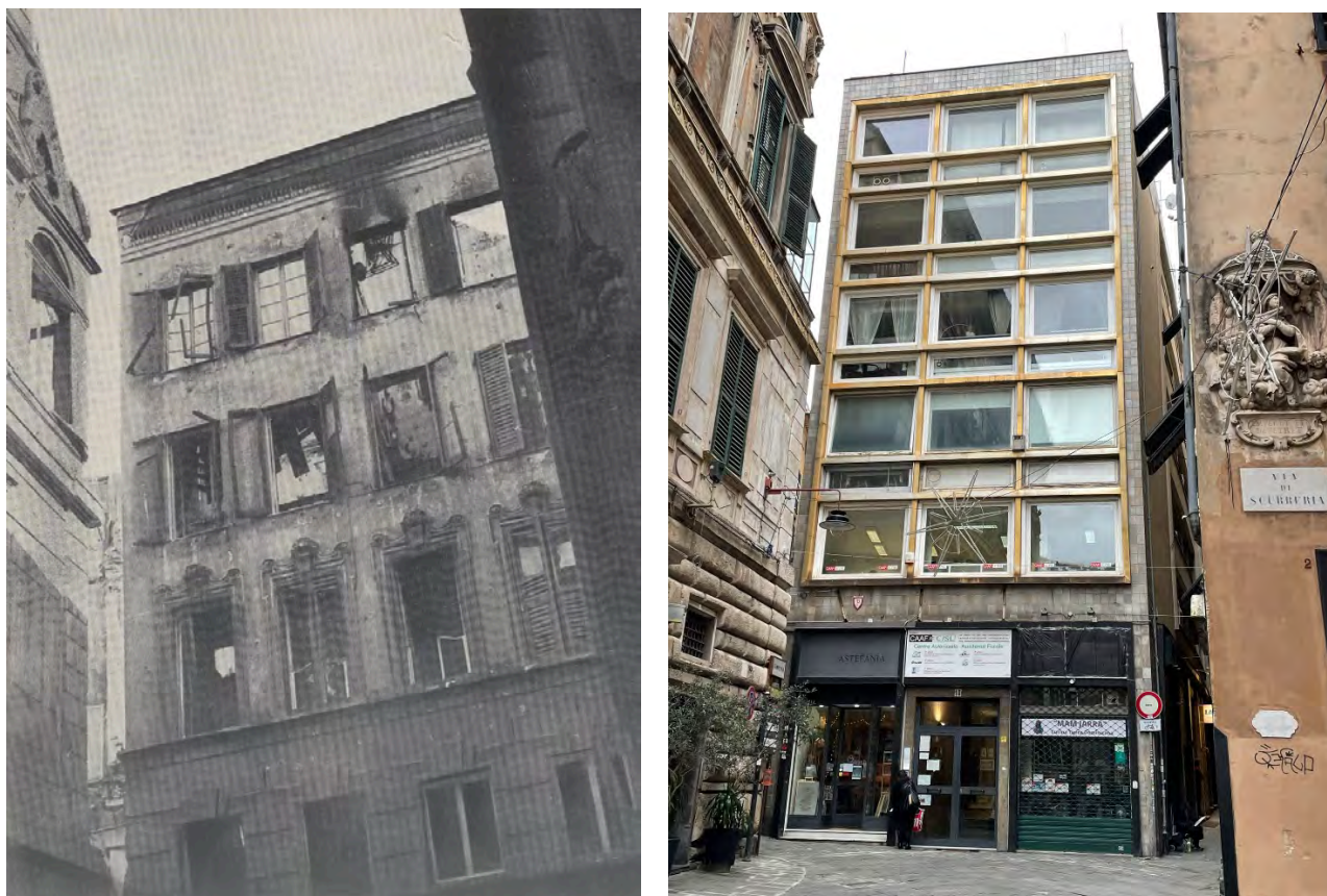
6: Genova, edificio in Campetto n.10. A sinistra dopo i danneggiamenti che ne hanno decretata la demolizione (immagine tratta dalla rivista «Genova», settembre 1943). A destra l'edificio ricostruito dall'arch. Luigi Falconi, 1952-54 (foto L. Napoleone).
