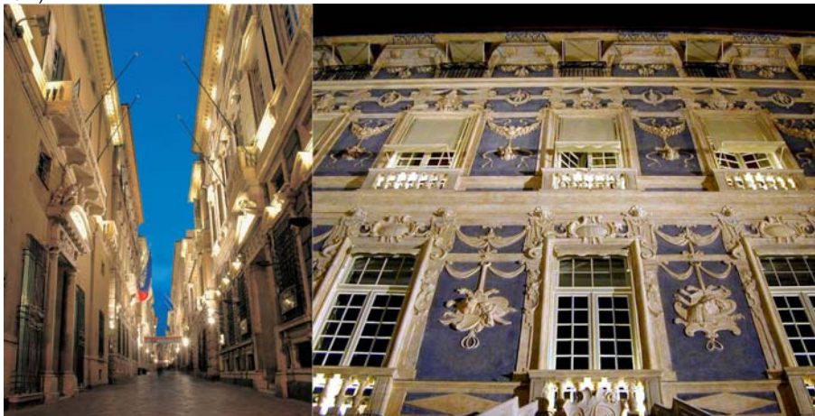
Fig.4 Via Garibaldi a Genova. Intervento di riqualificazione tramite un progetto d' illuminazione scenografica dei palazzi della via. La strada-museo è valorizzata da un sistema di corpi illuminanti che valorizzano la partitura delle facciate e le valenze cromatiche anche in notturna. Camera di Commercio, Egl Italia. (2005) [4]
